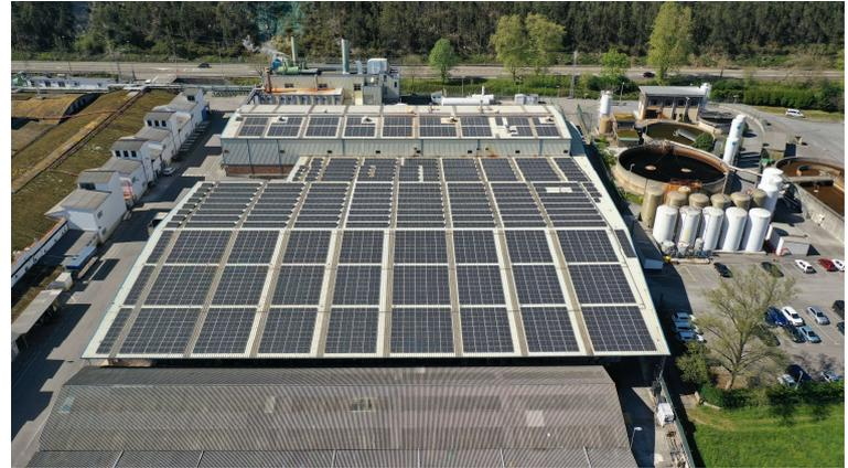
Concienciados de la importancia de reducir nuestras emisiones de dióxido de carbono (CO<sub>2</sub>), por un lado, contamos con la instalación de células fotovoltaicas realizada en el año 2020, supuso una producción de electricidad de 804.532 kW en el año 2023, con previsión de duplicarlo de cara a los años 2024.2025, con lo que supondría una reducción de emisiones de 400 T eq CO<sub>2</sub>.
